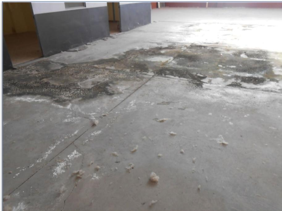
**Foto 22 infiltrazioni dalle finestre aperte sulla copertura**
